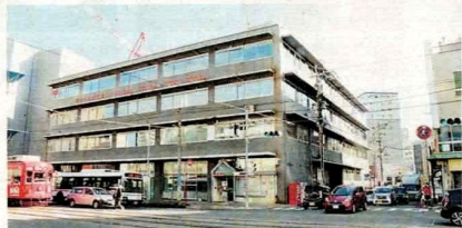
2028年度に尾上町へ移転予定の長崎中央郵便局。右側が拡幅される市道で、国道202号に通じている
