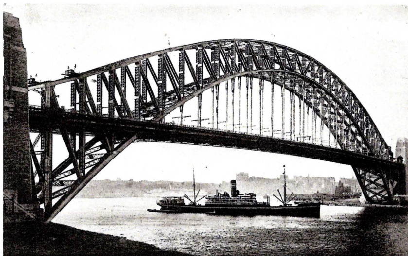
シドニーハーバー橋(漢洲シドニー) 水面よりの高さ四四〇呎、水面より歩車道迄の高さ一七〇呎、全長一、六五〇呎、一九三二年三月建
