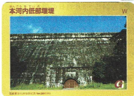
本河内低部堰堤 (国重要文化財) (長崎)
